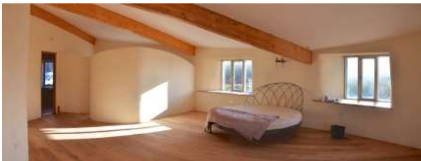
Illustration 2: Intérieur maison en bauge
